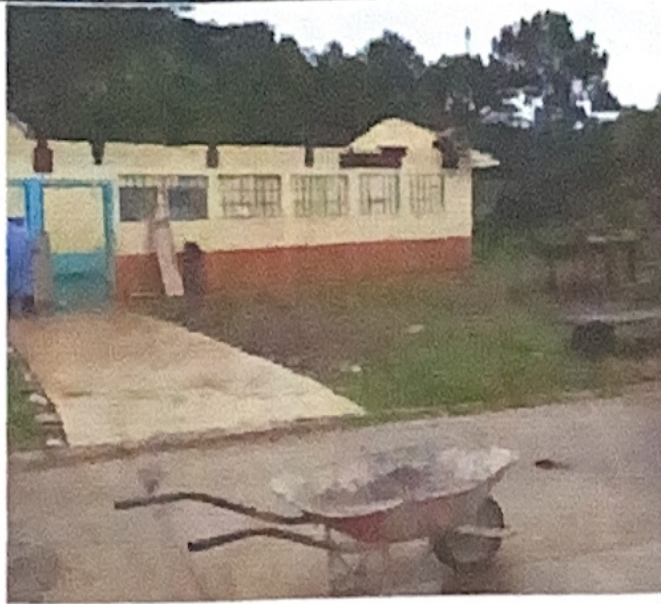
Foto 1: Se quito las vigas y laminas.
