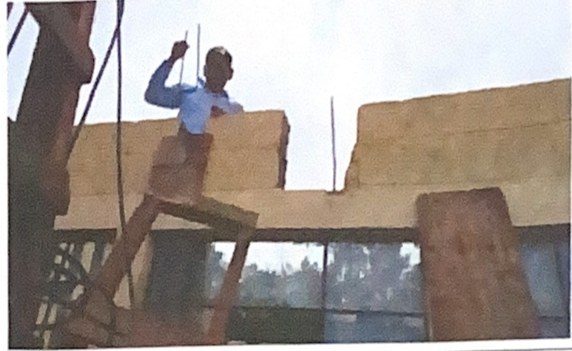
Foto 2: Fundir el lugar de la costanera
