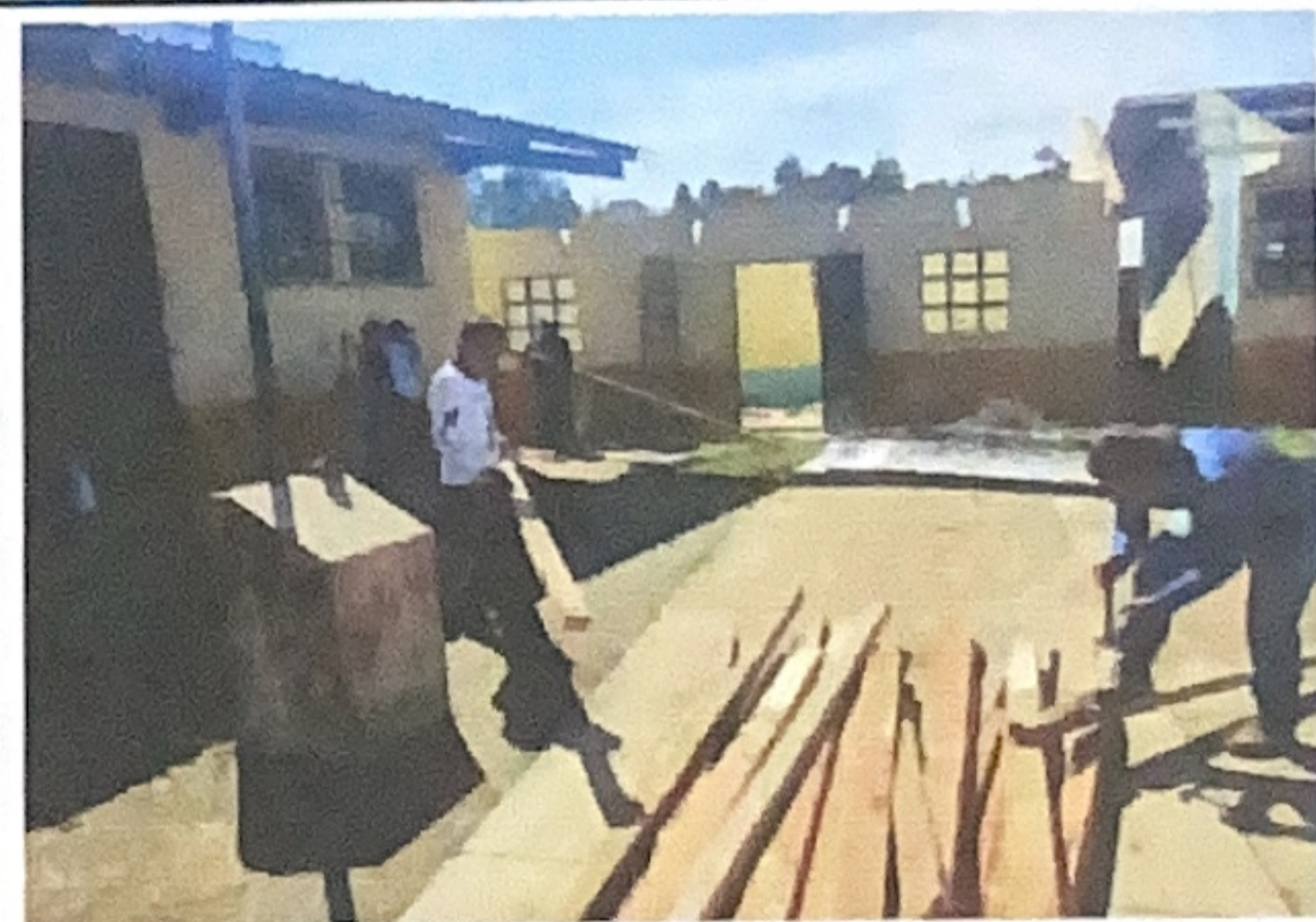
Foto 6: Quitando las vigas de las aulas.
